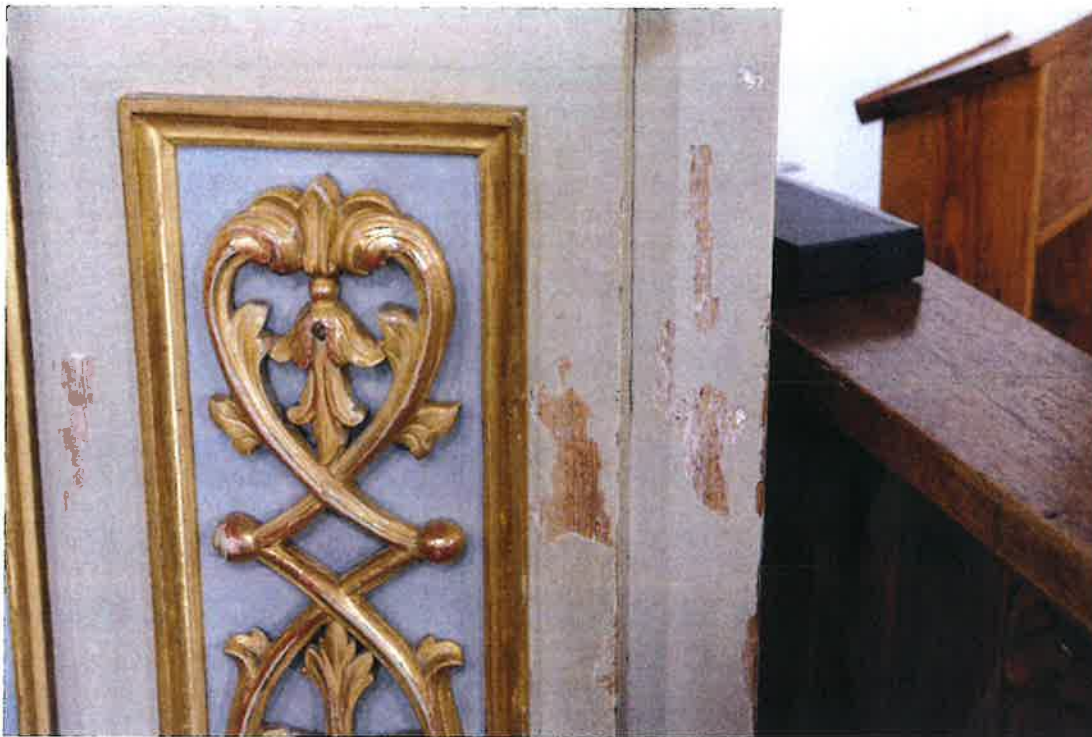
Fot.3 Ołtarz pod wezwaniem Najświętszej Marii Panny .Stan przed konserwacją, widoczne ubytki warstwy malarskiej wraz z zaprawą do drewna
