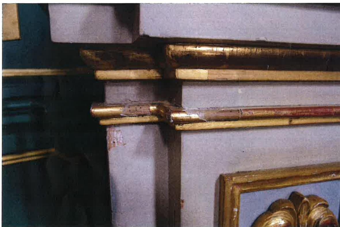
Fot.2 Ołtarz pod wezwaniem Trójcy Świętej. Stan przed konserwacją ,widoczne ubytki pozłoty z warstwą zaprawy do drewna i otwory na drewnie po działalności drewno jądów.
